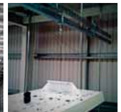
Luminaires, Armatures, Panneaux rayonnants, Conduites d'air
